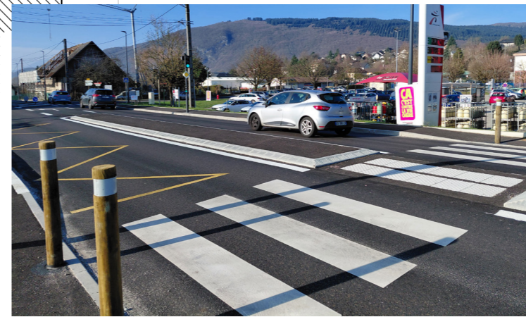
Suite à la réalisation des travaux
